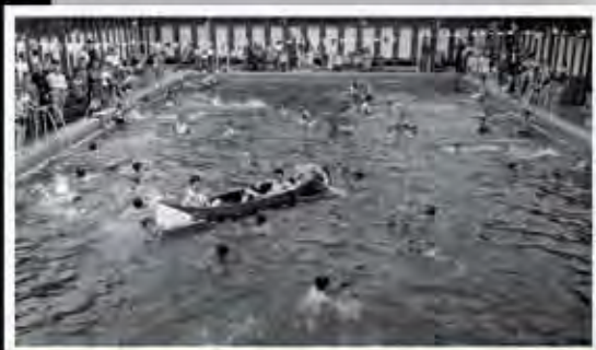
→ Année 1950 - Piscine extérieure
