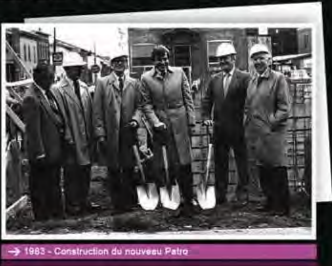
→ 1983 - Construction du nouveau Patro
